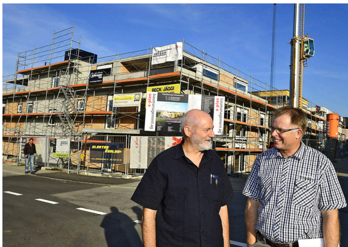
Sie sind zufrieden mit dem bisherigen Verlauf der Überbauung Ochsenweid: Investor Hanspeter Jaggi (links) von der Fenaco-Gruppe und Valentin Kappenthuler, Bauleiter der X-plan Baumanagement AG.
